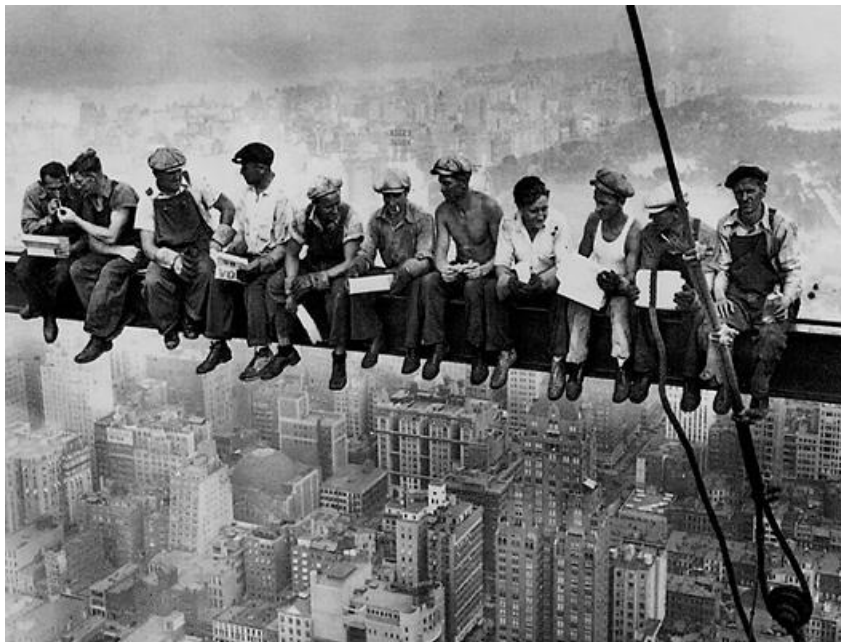
Serie fotográfica “Workers”, Edificio Empire State, 1931.
